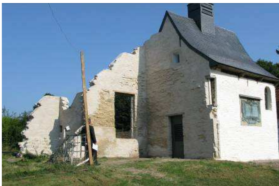
La chapelle restaurée
